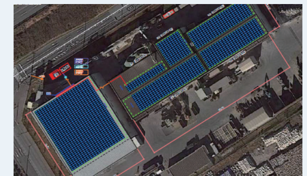
千葉工場の太陽光発電設備 全景
