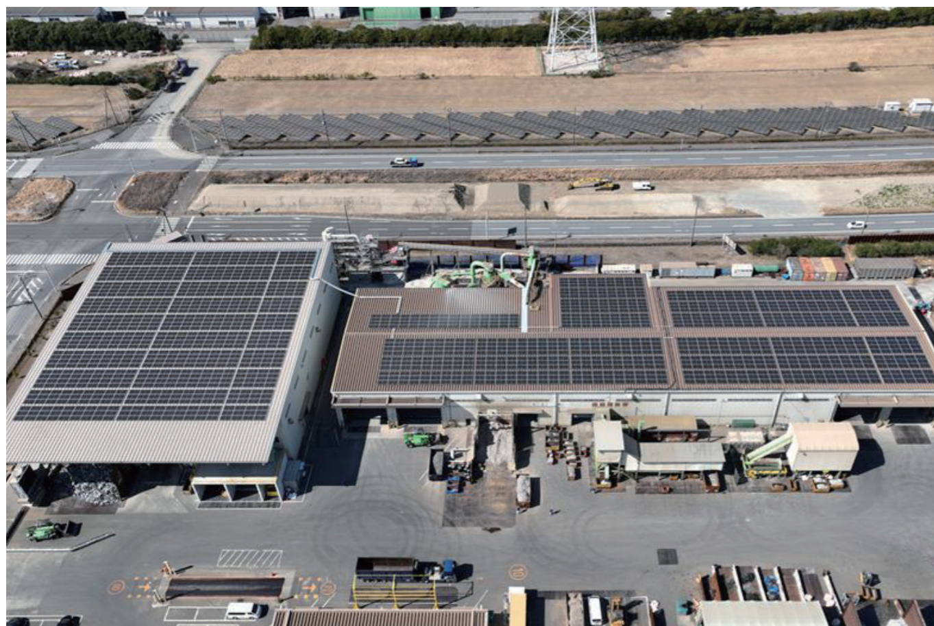
太陽光パネルを設置した東港金属千葉工場全景
